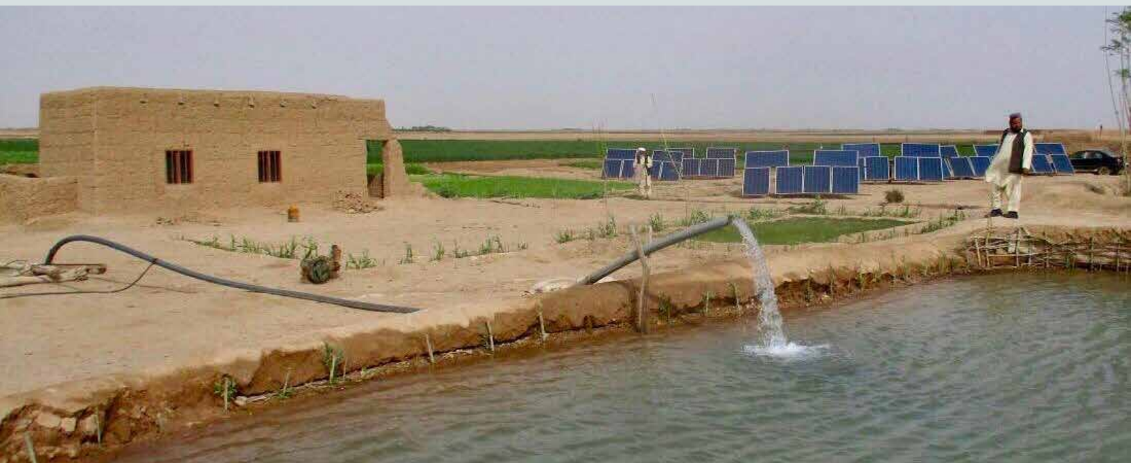
شکل ۴: دهقان در حال بررسی یک چاه عمیق با برق آفتابی در هلمند.
